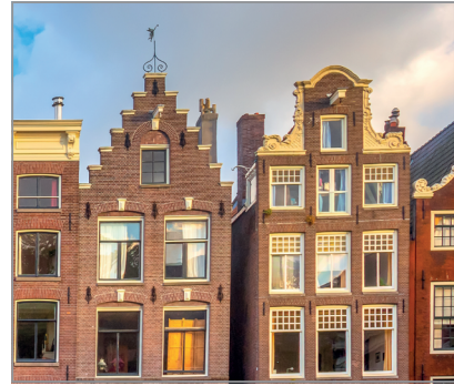
de trapgevel en de klokgevel
