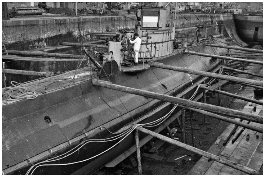
Het bevestigen van degaussing aan een onderzeeboot door de Koninklijke Marine in 1939.
