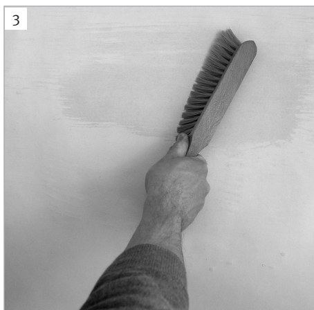
plaksel aanbrengen met een behangborstel
